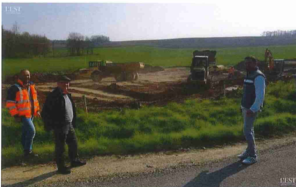
Le site retenu pour la nouvelle usine se trouve sur le parcours de la canalisation qui transfère l'eau de la station vers le château d'eau de Saint-Germain. Photo ER /D.H.
